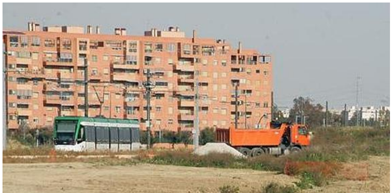
El nuevo vial de interconexión del campus va paralelo a la línea del metro y las obras tienen un plazo de ejecución de cinco meses. / Fernando González
